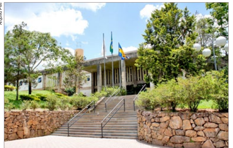
Prédio principal da Prefeitura receberá as ações de economia de energia
