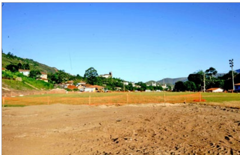
Obras no Complexo Esportivo Água Limpa
