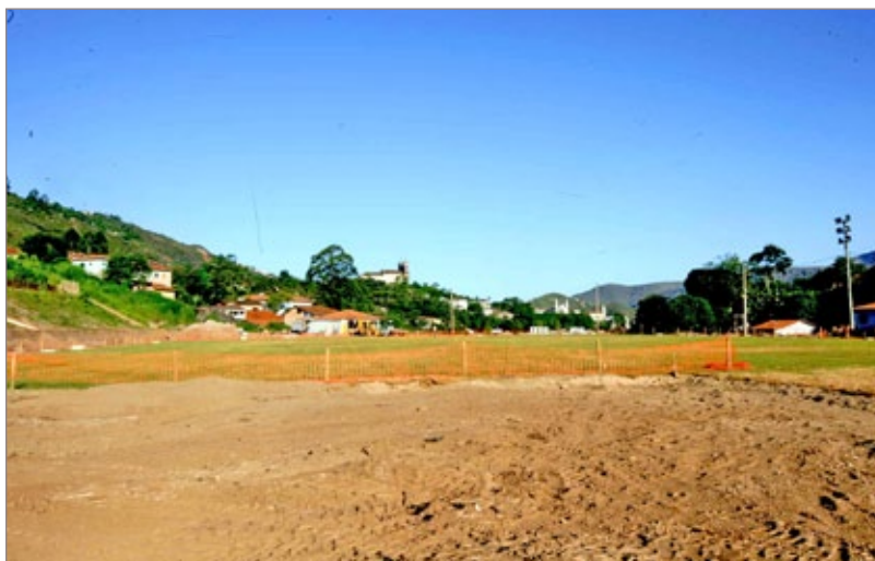
Obras no Complexo Esportivo Água Limpa
