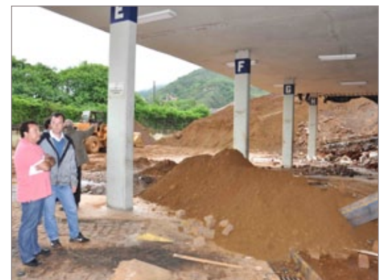
Trabalhos de recuperação continuam intensos na Rodoviária de Ouro Preto
