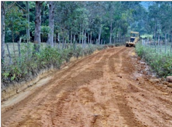
Patrulamento e encascalhamento em Serra dos Cardosos
