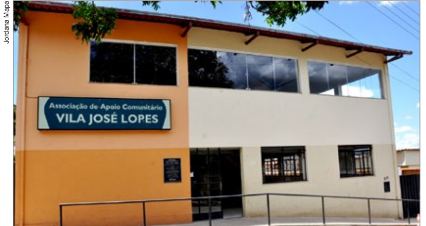
Associação Comunitária do bairro Vila José Lopes recebe novo consultório odontológico e sala de informática
