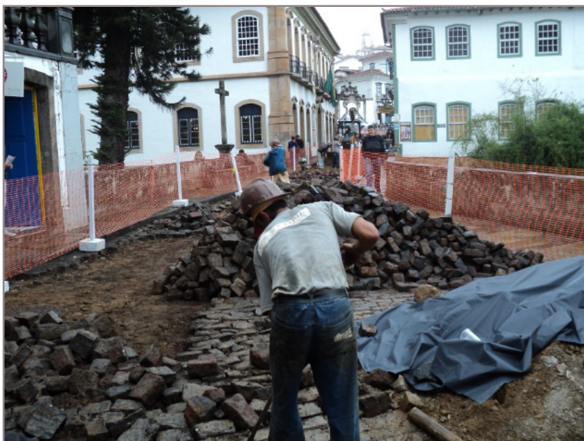
Obras prosseguem a todo vapor em contraste com as reclamações de moradores e comerciantes
