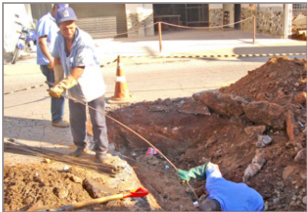
Intervenção em rede de esgoto no Catete Natália Sales
