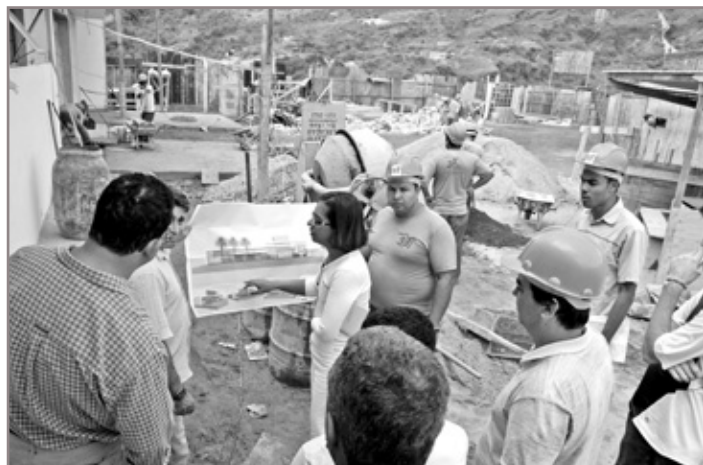
Equipe técnica acertando os últimos detalhes da obra
