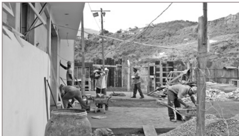
Obra está em fase de acabamento
