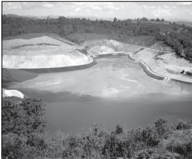
Com 15 m de profundidade, barragem em Acuruí da MSol abriga rejeitos tóxicos de alta periculosidade
