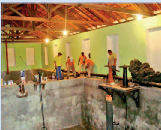
Reforma do Reservatório do Marambaia
