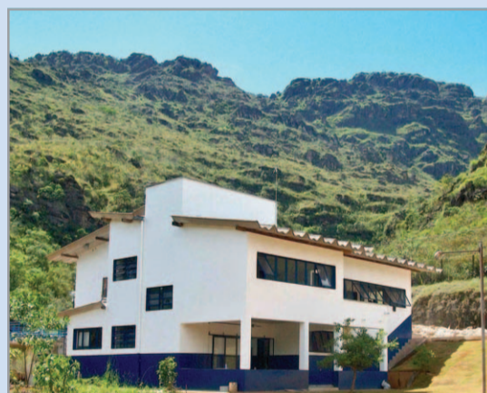
Estação de Tratamento de Água do Itacolomy
