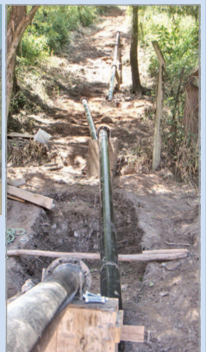
Obra de Interligação da Caixa III com o Reservatório de Marambaia
