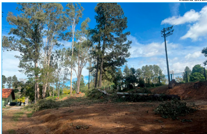
Área começou a ser preparada para futuras instalações
