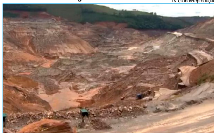
Imagem da barragem
