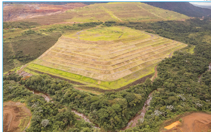
A barragem Xingu, na cidade de Mariana, passará pelo processo de descaracterização que deve ser concluído ainda em 2025
