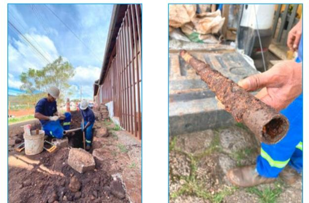
Uma obra de melhoria no abastecimento de água para os moradores da Bauxita foi iniciada após uma manutenção emergencial na Rua Antônio José Ramos. Após reclamações de falta d'água na região, a equipe técnica realizou vistorias e verificou que a rede estava obstruída por ser muito antiga, de ferro e ter um diâmetro inadequado.
