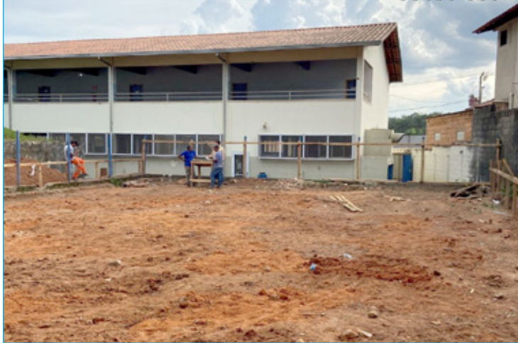
A expectativa é de que as obras sejam concluídas no segundo semestre deste ano. Atualmente, a obra está na fase de fundação.
