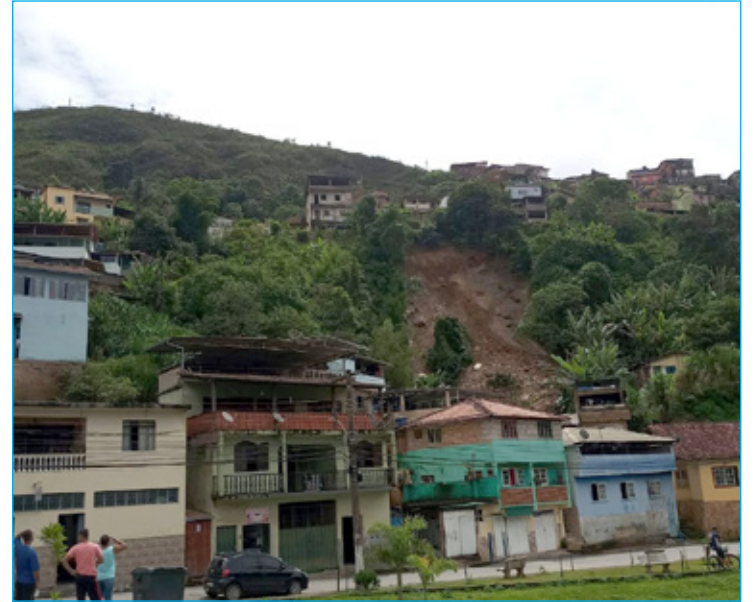
Deslizamento de encosta entre as Ruas Desidério de Matos e Francisco Isaac que ocorreu hoje (04/01) no Bairro Padre Faria
