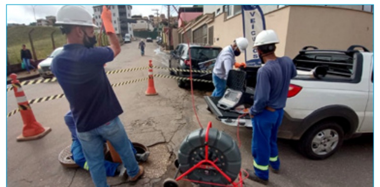
Seesnaker trouxe mais assertividade e agilidade nos serviços de monitoramento das redes de esgoto
