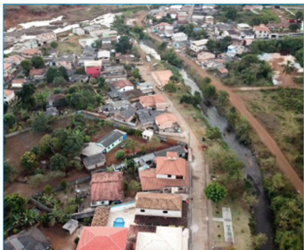
Muro será construído no Rio Tabuleiro
