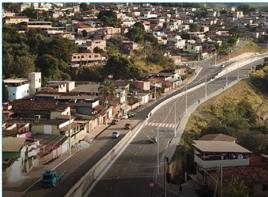
Avenida ganhou iluminação LED, sinalização viária entre outras intervenções
