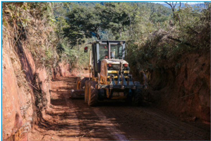
Obras já começaram na estrada que liga Catarina Mendes a Ouro Preto
