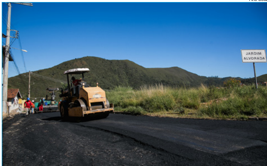
Rua Antônio Esteves Sacramento já está recebendo asfalto
