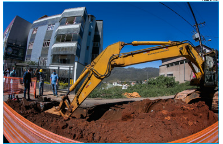
Obras na JK tiveram início dia 11
