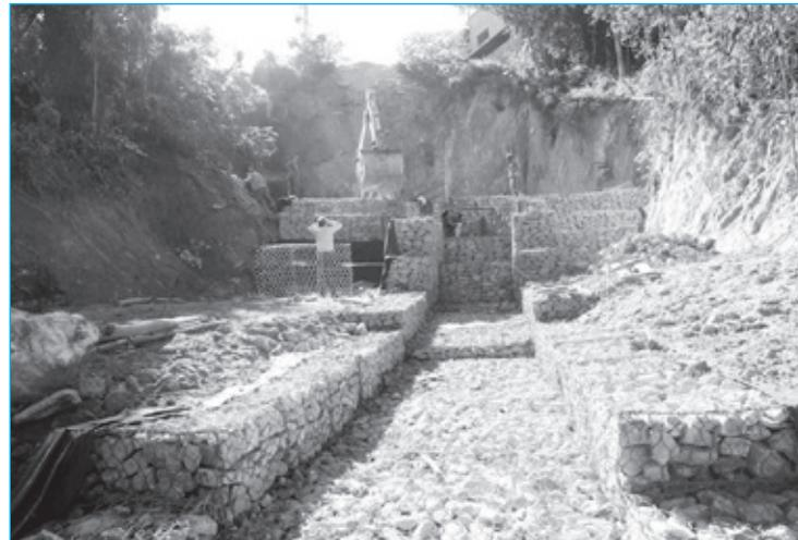
com 534 m3 de gabião e terramesh, que visa evitar o risco de desabamento sobre as casas existentes na localidade e promover o adequado escoamento das águas pluviais.
