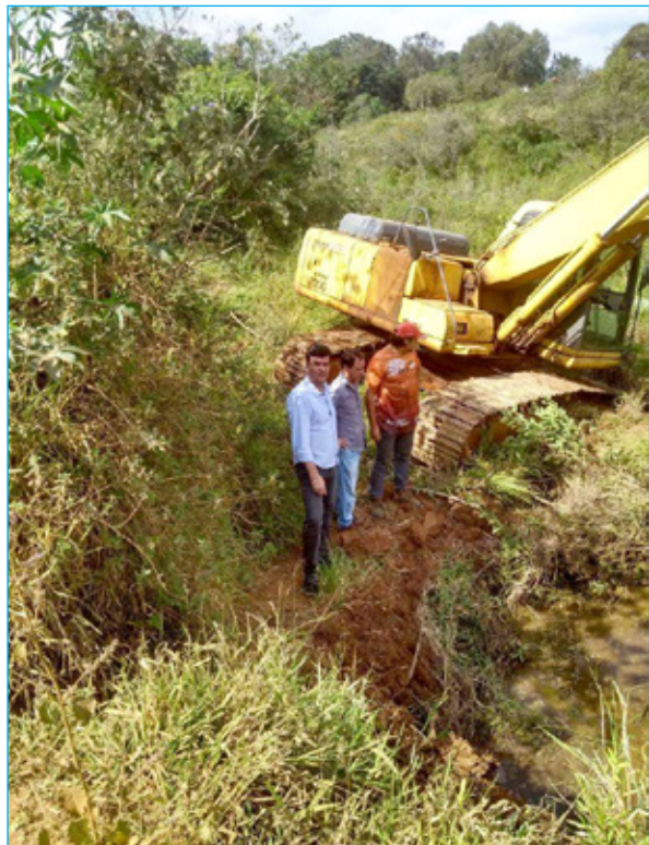
Wander Albuquerque e Tico Miranda fiscalizam o início das obras do córrego do Prata
