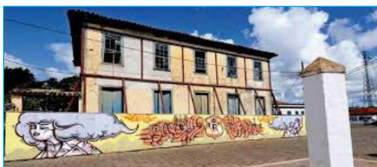
Casarão Solar Pedrosa - Cachoeira do Campo
