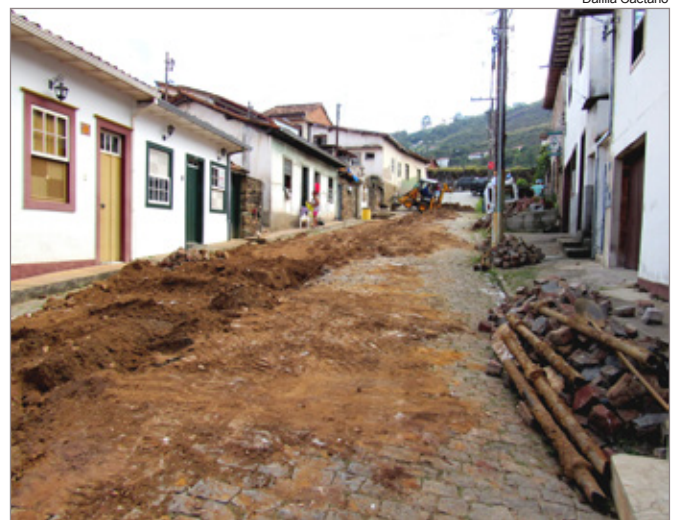
Smae substituiu rede de água na rua Barão do Ouro Branco
