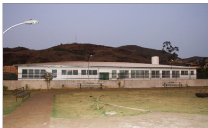
Prefeitura construiu um novo prédio para a UBS de Antônio Pereira
