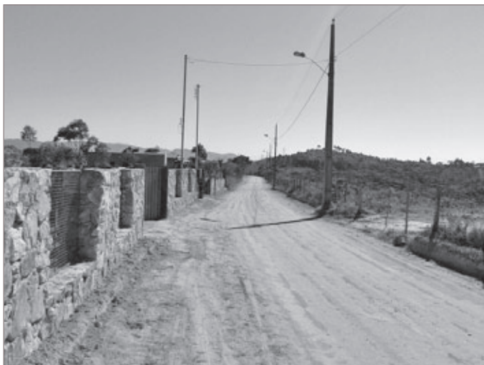
Bairro Mangue Seco receberá pavimentação
