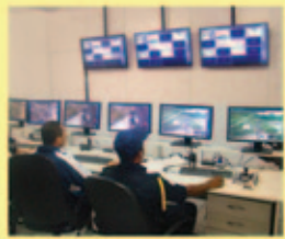
Sala de monitoramento do trânsito
