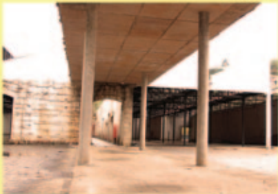
Obras do Espaço de Eventos na antiga fábrica de tecidos, bairro Padre Faria
