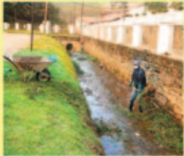
Limpeza dos córregos
