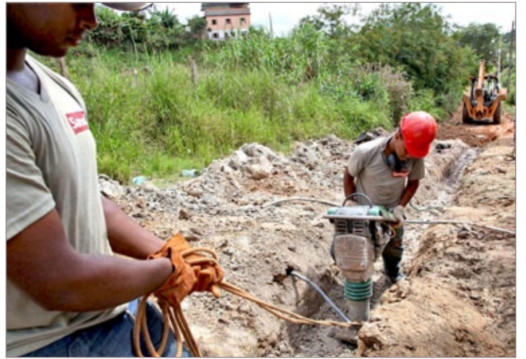
Esgotamento sanitário no Quinta dos Inconfidentes
