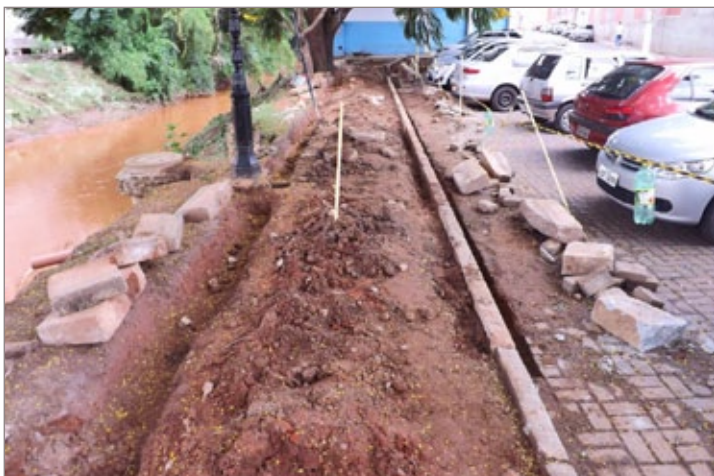
O processo de revitalização do Largo dos imigrantes já foi iniciado
