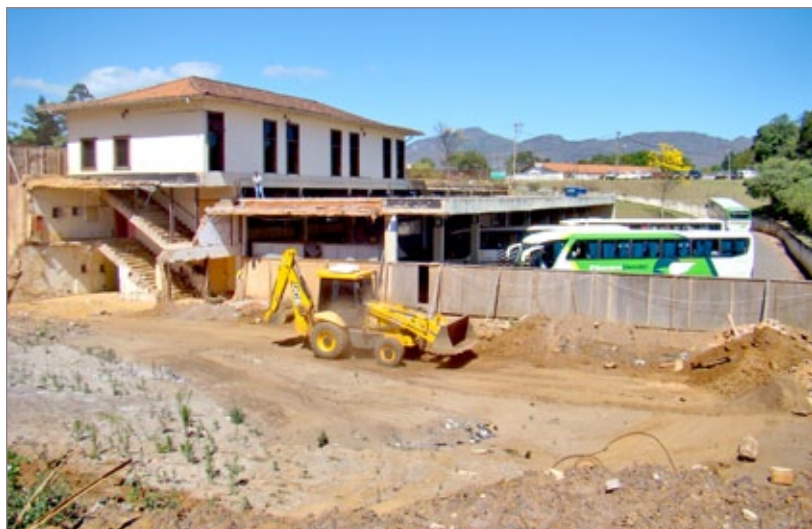
Obra de recuperação no Terminal Rodoviário 8 de Julho, realizadas pela Prefeitura de Ouro Preto
