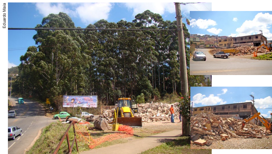
Edificação demolida dará lugar à rotatória que ligará a Bauxita à BR-356
