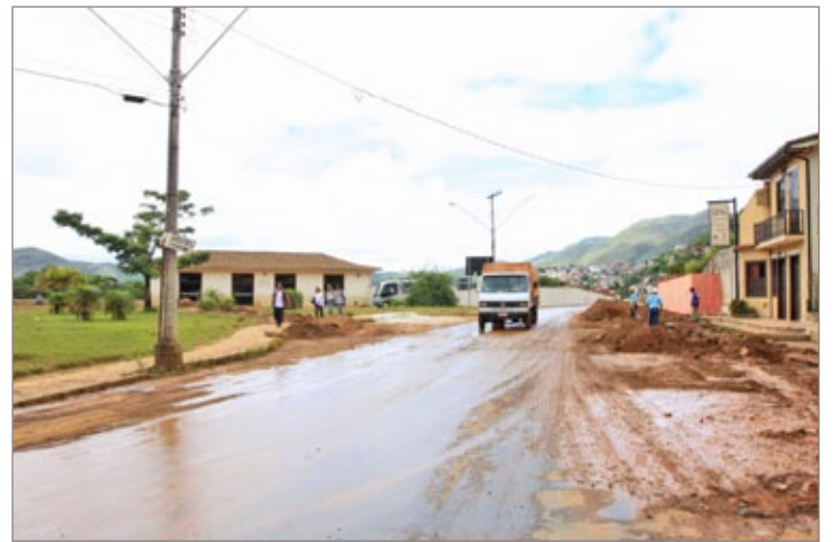
Rodoviária de Ouro Preto após os danos causados pelas chuvas
